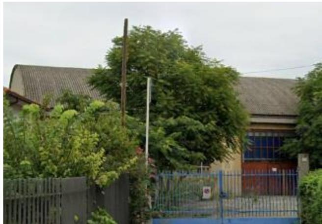
Figura 28. Due esempi di dettagli su due punti di verità a terra rappresentativi di coperture in cemento amianto tuttora in posto, visualizzati da immagini aeree recenti, e verificati ulteriormente con osservazioni dirette (da drone nel primo caso e con immagini da terra nel secondo).
